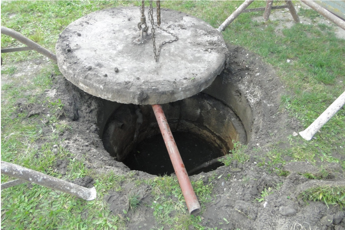
Figure 3 : Ouverture du puits 3 non utilisé depuis des années
